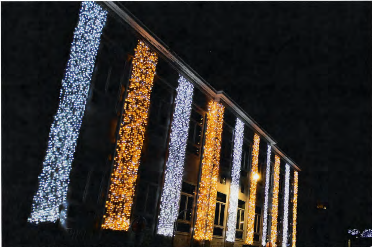
Glittering Curtain Lights - Live Photo & Video: https://youtu.be/H_IDQkVoVq8
